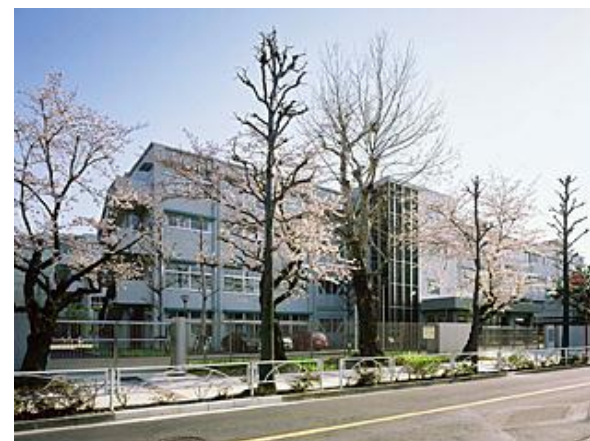
東京都/ 都立中等教育学校(仮称)(14) 増改修工事実施設計 (H14)
