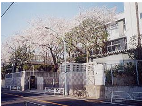
東京都/ 都立広尾高等学校(11)大規模改修工事 実施設計及び監理業務 (H13)
