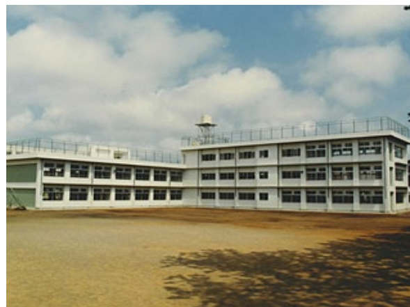
二宮町/二宮中学校特別教室棟改築 (S60)
