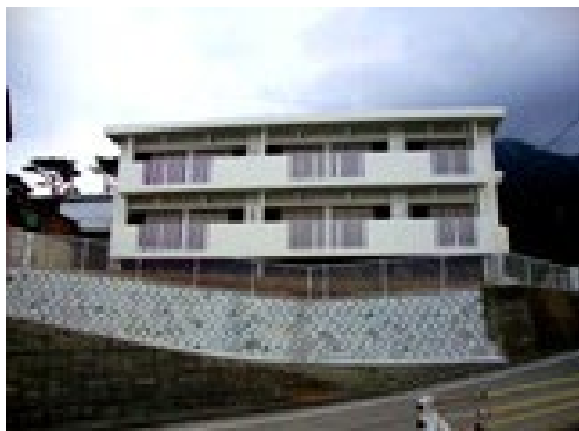
御蔵島村/ 御蔵島かんぶり515住宅新築設計(H20)
